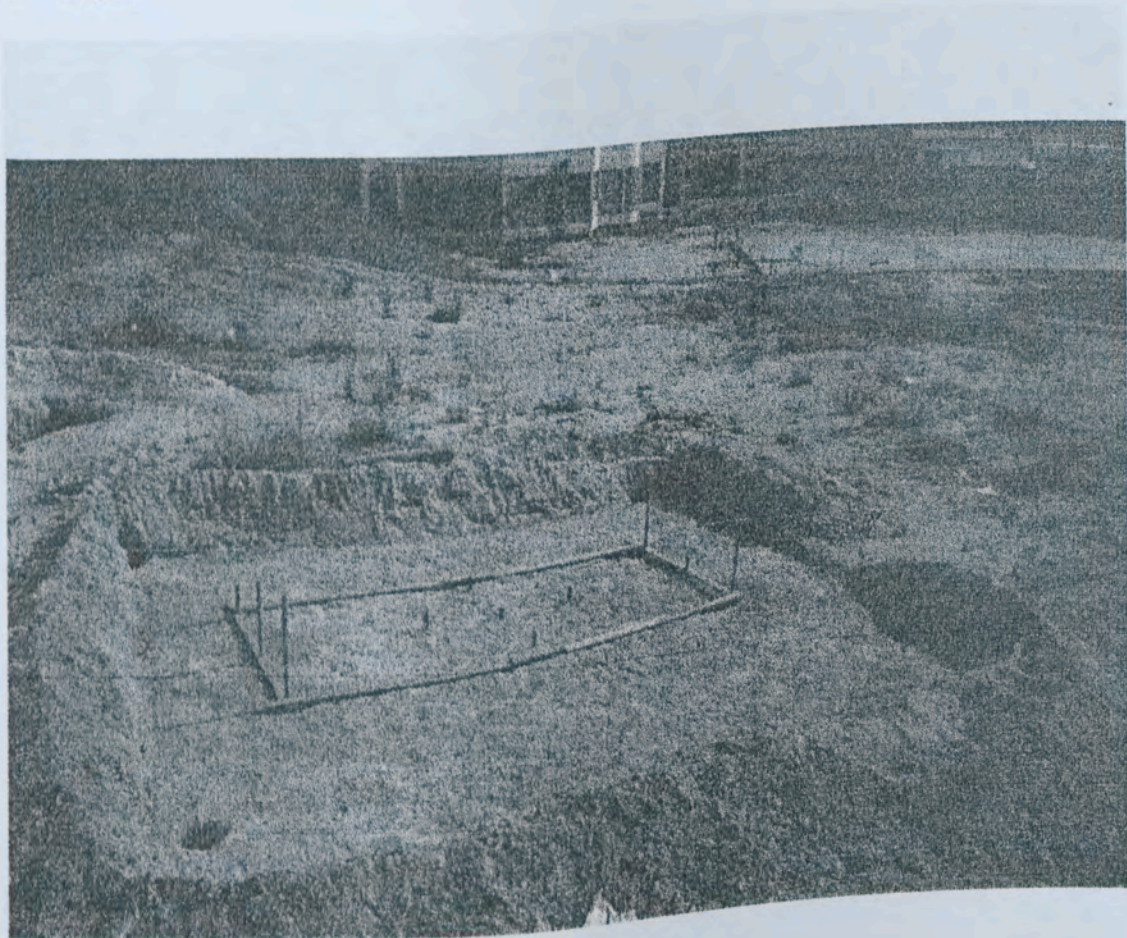
Figura 47 - Preparação superficial do local da prova de carga.
