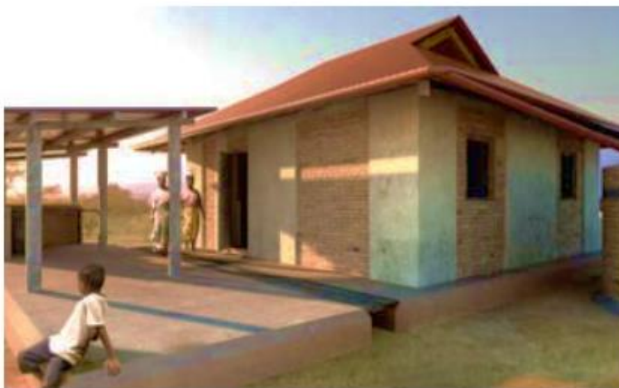
Figura 6 - Casa resistente a sismos construída com materiais convencionais
