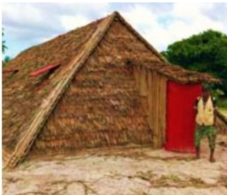
Figura 5 - Abrigo resistente a ciclones, construído com materiais tradicionais
