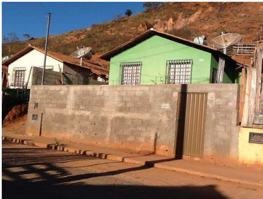
Figura 20 – Casa com muro, portão e grades na porta e nas janelas, no conjunto habitacional César Santana Filho. Viçosa, MG. Fonte: dados da pesquisa, 2014.
