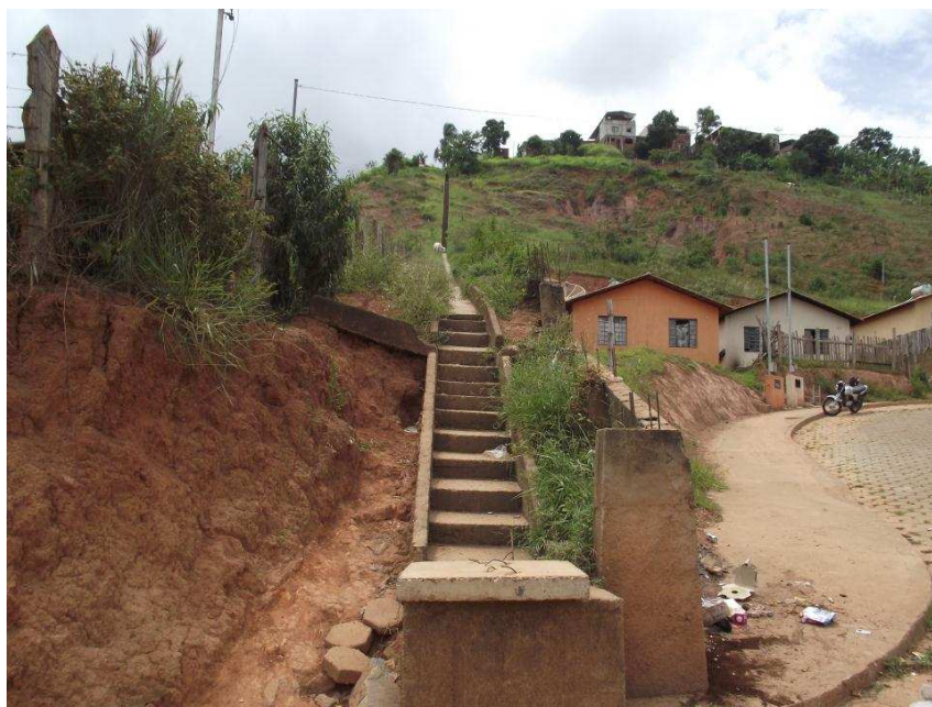
Figura 15 – Escadão. Escada hidráulica muito utilizada de forma improvisada para acesso ao bairro Santa Clara pelos moradores do conjunto habitacional César Santana Filho. Viçosa, MG.
