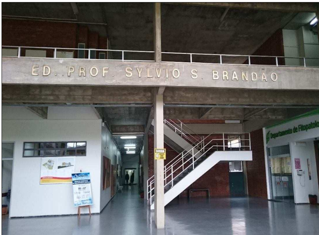
Figura 14: Hall de entrada do prédio Sylvio Starling Brandão.
