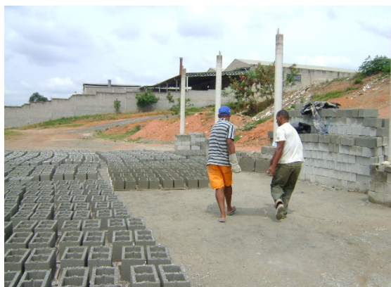
Foto 10: Recuperandos trabalhando na Fábrica de Blocos da APAC de Itaúna
