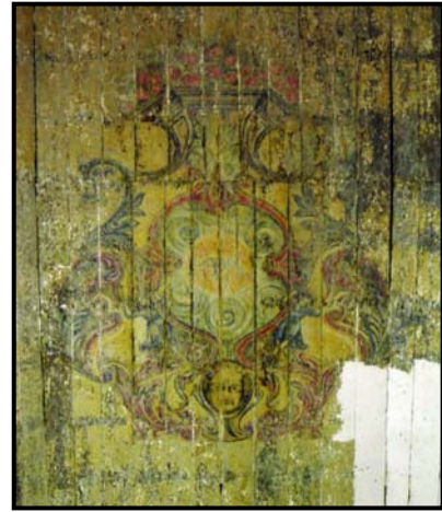
Figura 11: Forro da Capela-mor após remoção da repintura. Dossiê de restauração, agosto de 2006.
