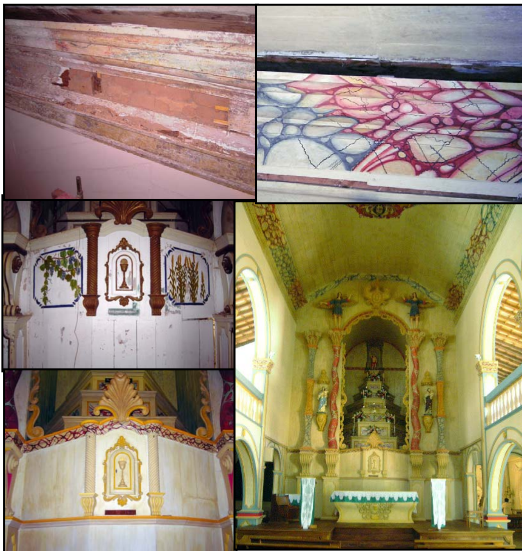
Figura 13: O “antes” e o “depois” da restauração. Dossiê da restauração, agosto de 2006.
