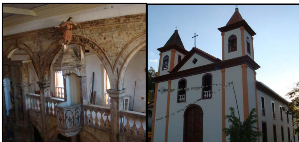
Figura 15: Remoção de repintura na nave central. Pesquisa de campo, junho de 2010. Fonte Wander Torres Costa
