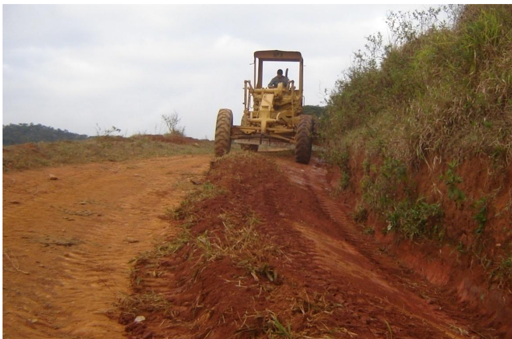
Figura 17 - Construção do canal de drenagem da estrada.
