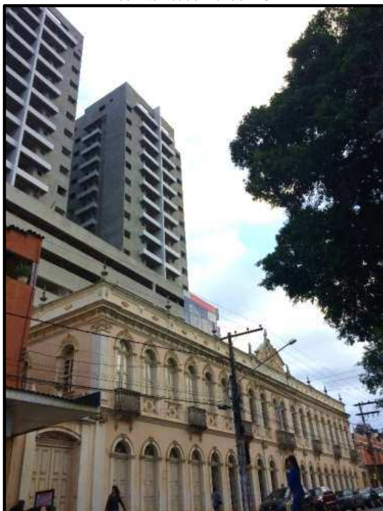
Figura 34 – Edifício sendo construído no lote posterior ao bem tombado Muriaé-MG
