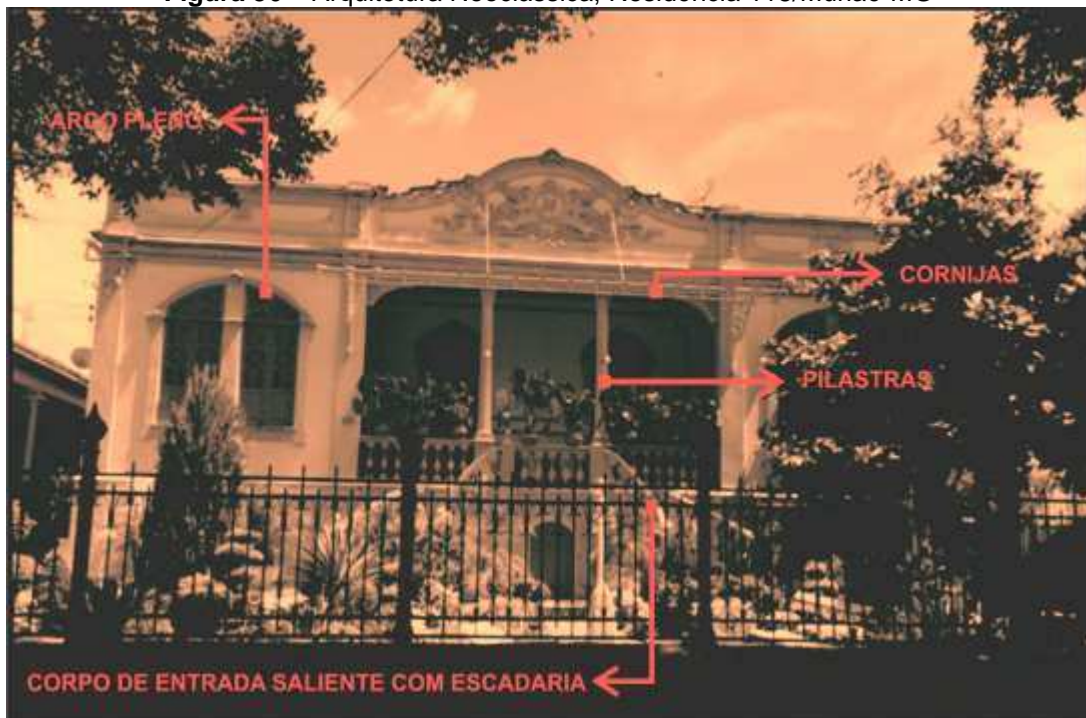
Figura 36 – Arquitetura Neoclássica, Residência 118/Muriaé-MG
