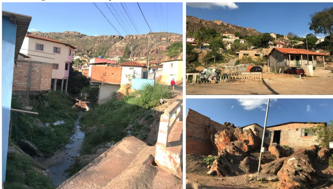
Figura 46 – Edificações do Bairro Rio Grande, na Serra dos Cristais
