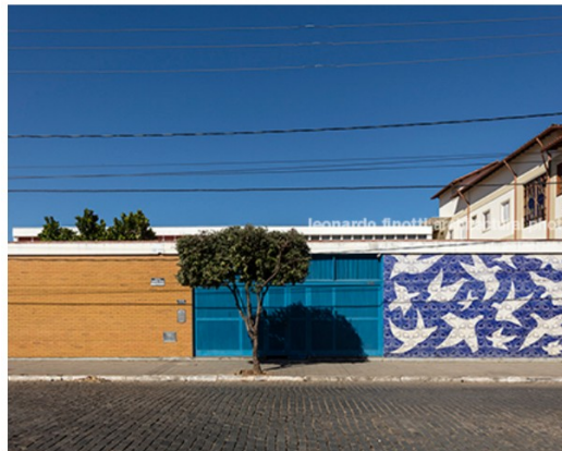
Imagem 35 - 16. Prédio do Educandário Dom Silvério
