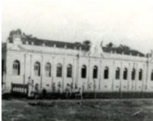
Imagem 34 - 15. Prédio do Edifício do Antigo Grupo Escolar Coronel Vieira
