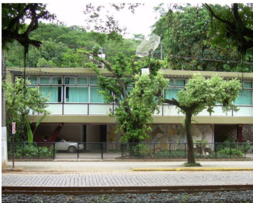
Imagem 22 - 3. Prédio da Residência A.O.Gomes
