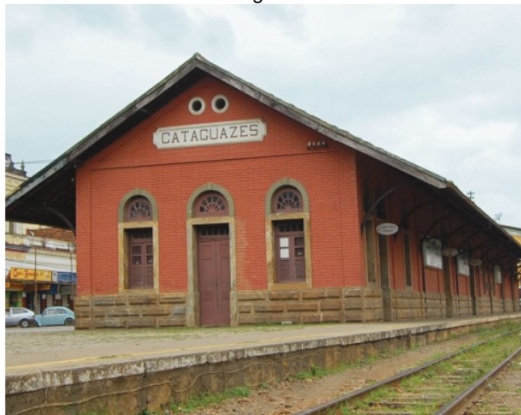
Imagem 32 - 13. Prédio da Estação Ferroviária de Cataguases
