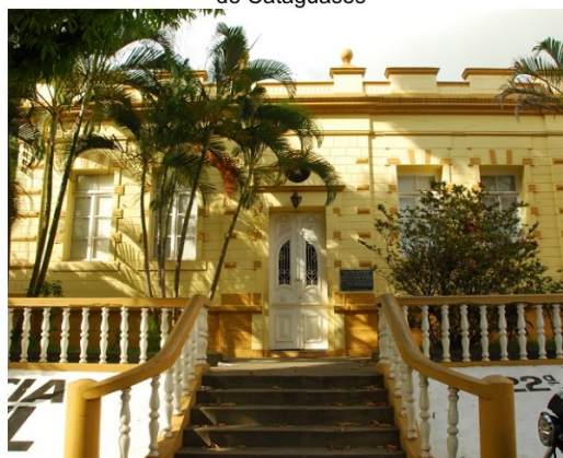
Imagem 46 - Prédio (fachada) da Delegacia de Polícia de Cataguases
