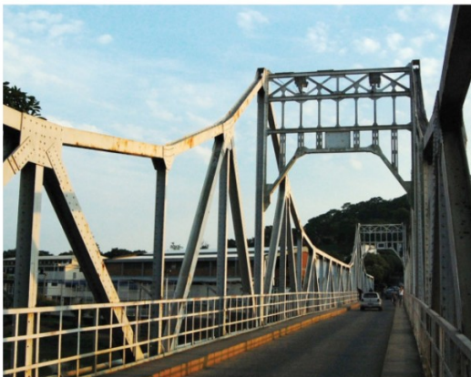
Imagem 30 - 11. Ponte Metálica sobre o Rio Pomba
