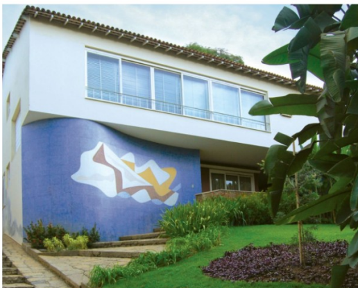
Imagem 24 - 5. Prédio da Residência de Nélia Peixoto
