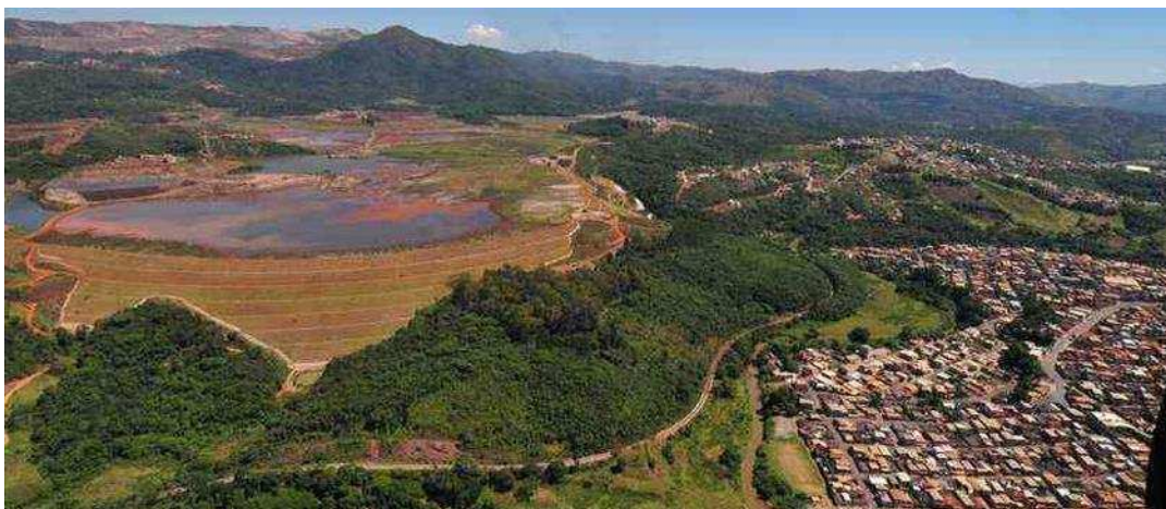
Figura 19: Barragem da mina Casa de Pedra em relação à cidade de Congonhas
