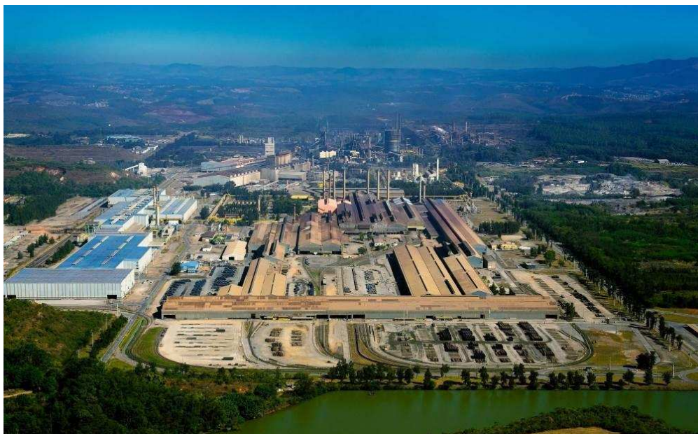
Figura 55: Vista aérea do complexo industrial da Gerdau.
