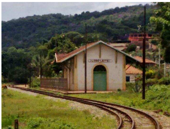
Figura 51: Fotografia da estação de Lobo Leite
