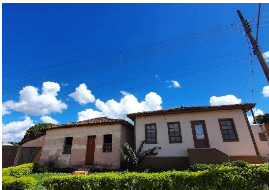
Figura 29: Fachadas de casarões antigos em Queluzito
