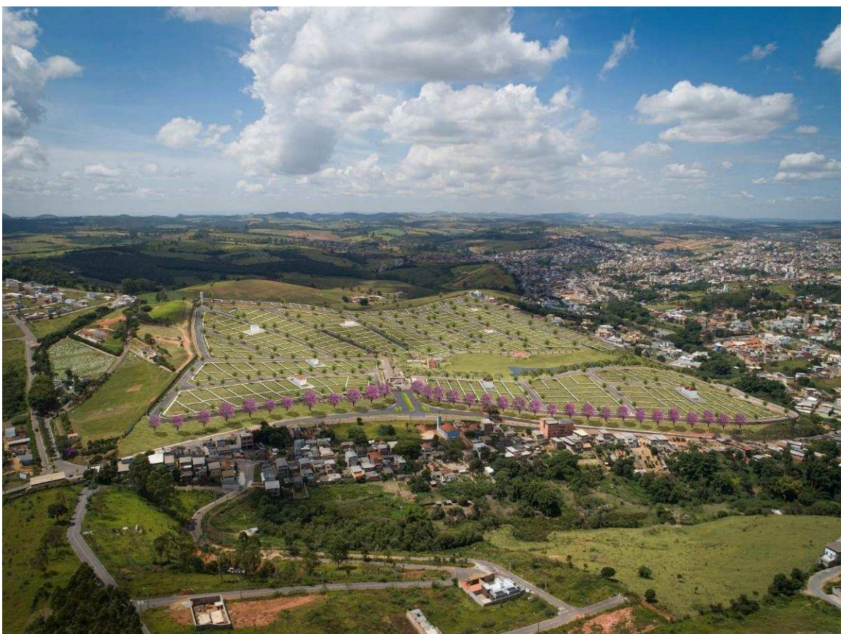
Figura 42: Imagem aérea de Conselheiro Lafaiete com montagem de maquete 3D do Condomínio Estiva
