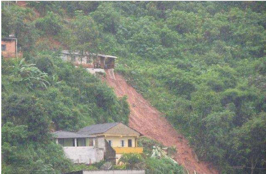
Figura 10 – Desmoronamento causado pela enchente em Manhumirim (MG) em 1997 Fonte: Portal Carangola. Disponível em: http://portalcarangola.com/chuva-provoca-estragos-em-manhumirim . Acesso em: mar. 2015.
