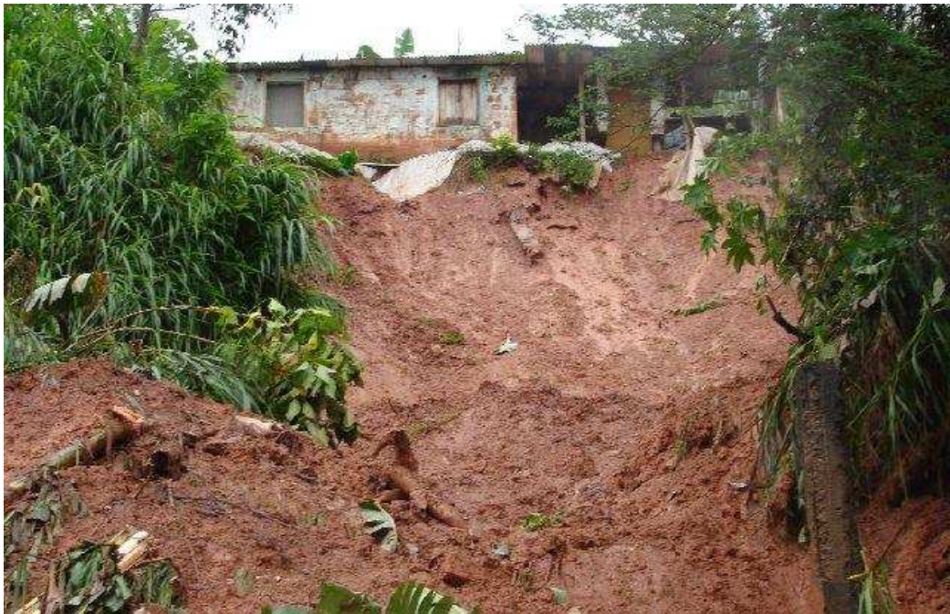
Figura 11 – Desmoronamento causado pela enchente em Manhumirim em 1997 Fonte: Portal Carangola. Disponível em: http://portalcarangola.com/chuva-provoca-estragos-em-manhumirim . Acesso em: mar. 2015.
