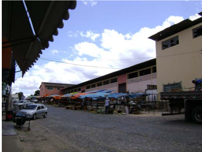
Figura 29: Visão externa lateral do Mercado Municipal de Araçuaí
