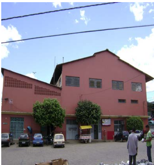
Figura 30: Vista externa inferior do Mercado Municipal de Araçuaí
