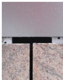
Figura 13 – Junta entre ACM e pedra
