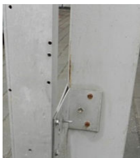
Figura 2 – Furações no perfil da fachada
