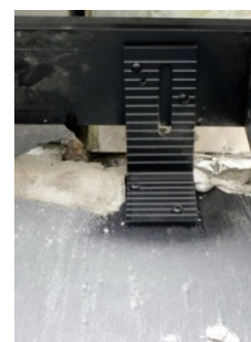
Figura 7 – Fixação da esquadria
