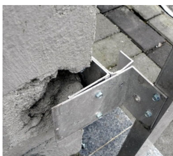
Figura 6 – Fixação da subestrutura da fachada
