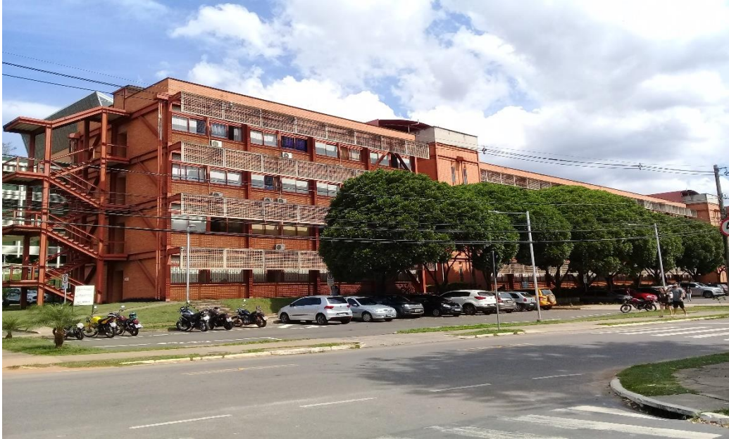
Figura 4 - Prédio do CCE
