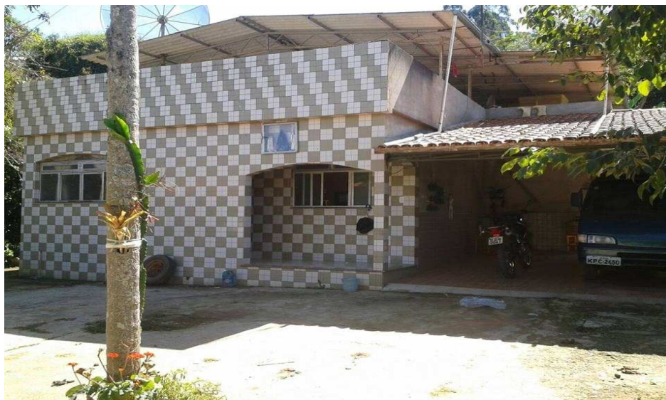
Figura 03- casa que será destruída para construção do mineroduto, Viçosa/Minas Gerais, 2014.
