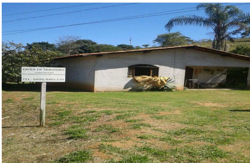
Figura 04- Casa que será destruída para a construção do mineroduto, Viçosa/Minas Gerais, 2014.
