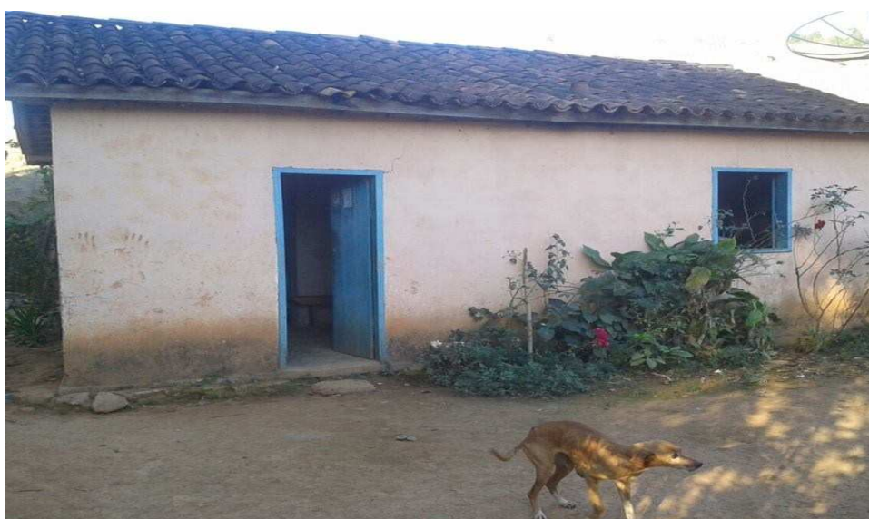
Figura 02- Casa que será destruída para a construção do mineroduto, no município de Paula Cândido/Minas Gerais, 2014.
