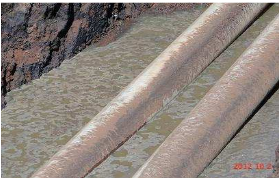
Figura 31 - Vazamentos em tubulações que transporta a vinhaça para as áreas fertirrigadas no município de Bambuí, MG.
