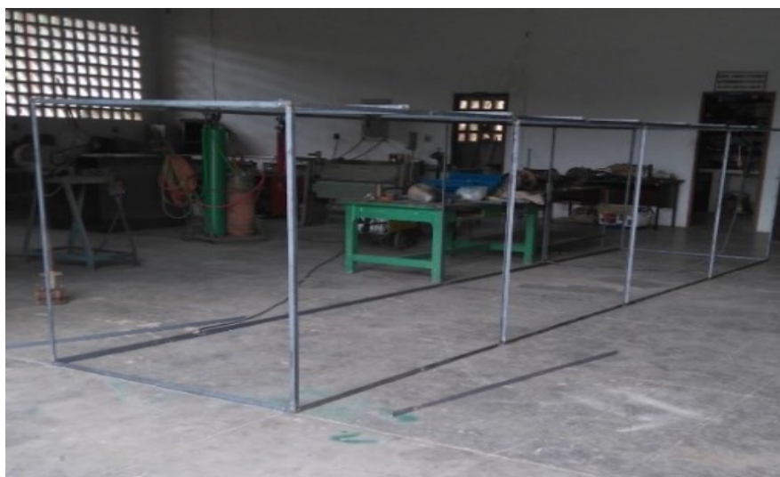
Figura 1 – Estrutura metálica do túnel de vento.
