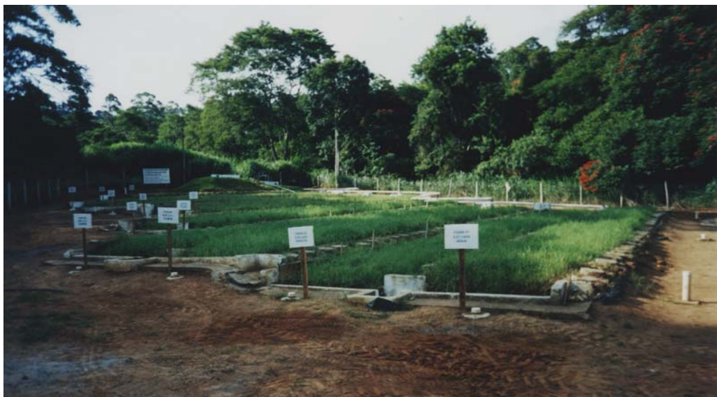
Figura 5A. Vista geral da Estação Experimental de Tratamento de Esgoto.
