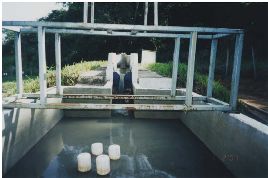
Figura 3A. Vertedouro de seção triangular com ângulo de 90^\circ .
