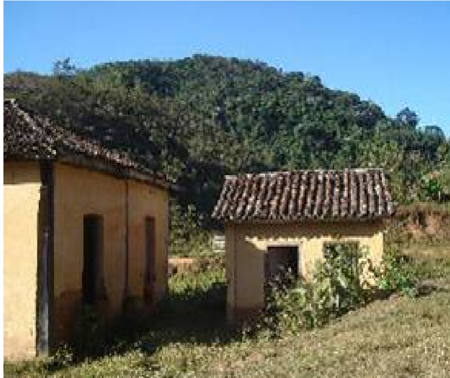
Figura 3 – Depósitos da Fazenda Quebra-Canoas.
