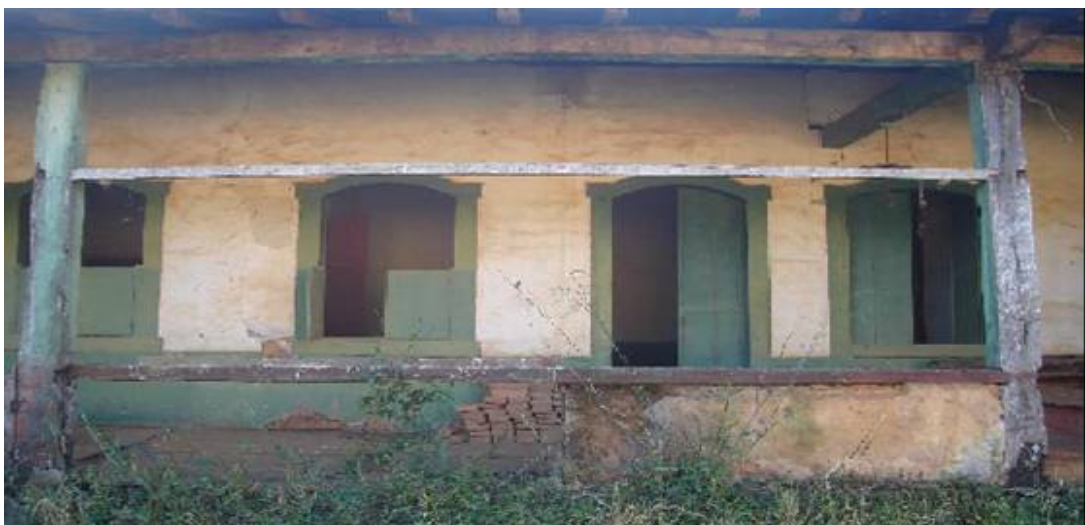
Figura 4 – Fazenda Quebra-Canoas: detalhe das janelas e da porta de madeira.
