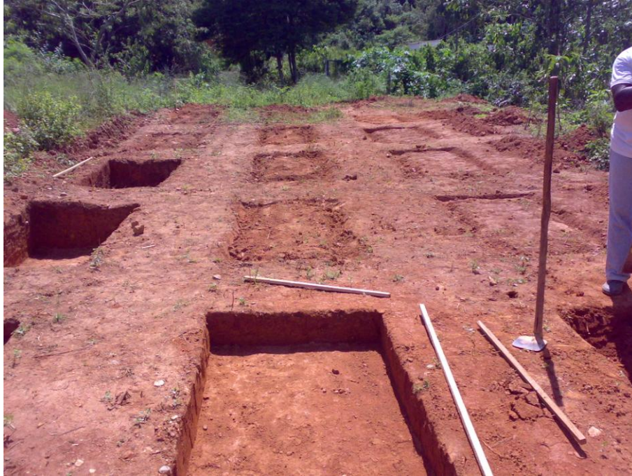
Figura 4 - Escavação para instalação dos reatores solares.
