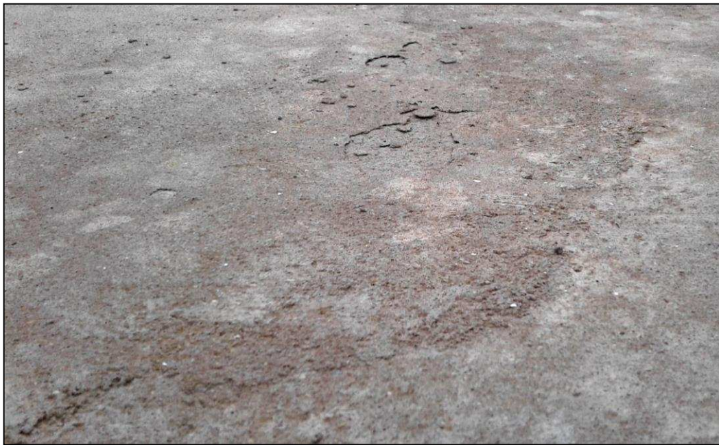
Figura 4-37. Desagregação do pátio executado com agregados de RCC.
