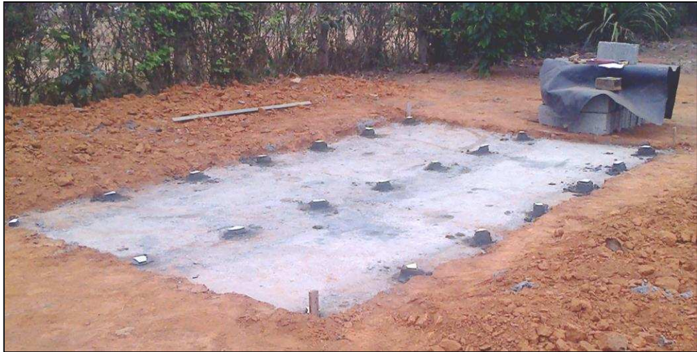
Figura 3-4. Nivelamento e gabaritação do terreno.
