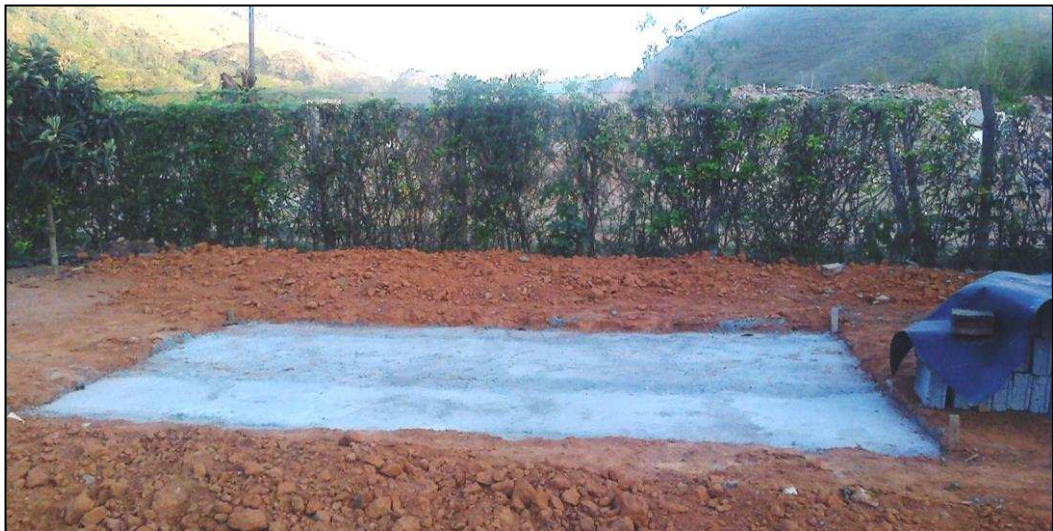
Figura 3-5. Execução da base.
