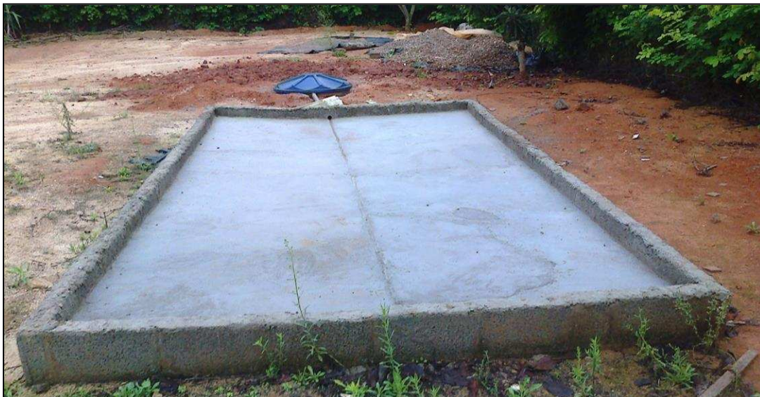
Figura 3-10. Pátio finalizado com a aplicação de argamassa.
