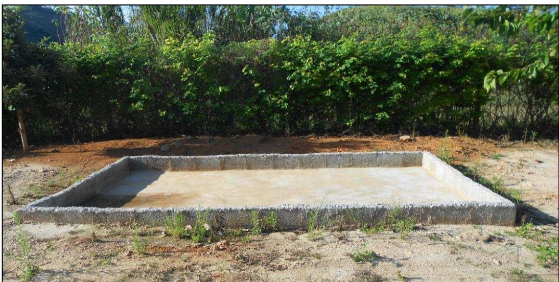
Figura 3-6. Colocação dos blocos.
