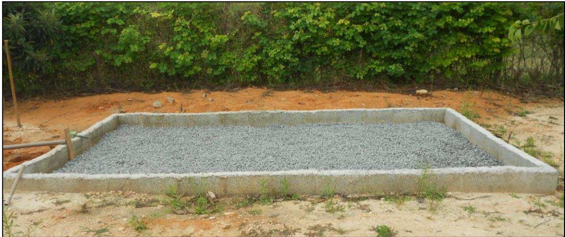
Figura 3-7. Execução da camada drenante.
