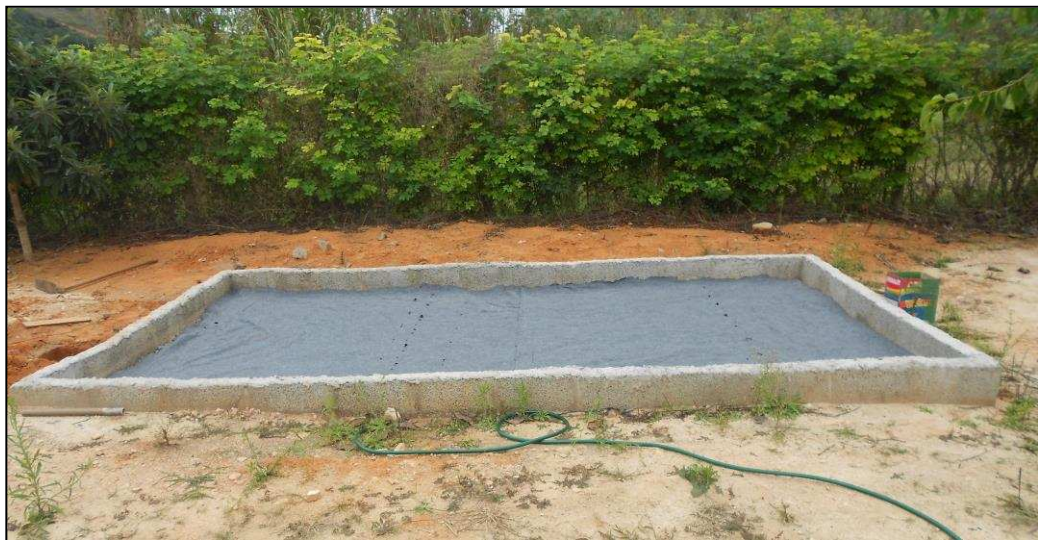
Figura 3-8. Aplicação da manta geotêxtil.
