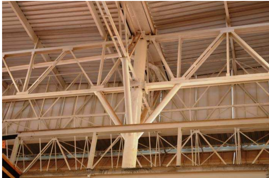
Figura 4.7 - Detalhe da ligação do topo das colunas A e D.
