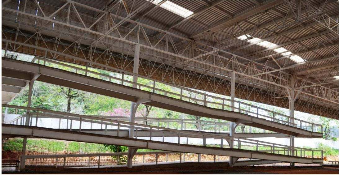
Figura 4.2 - Vista geral da rampa de acesso.
