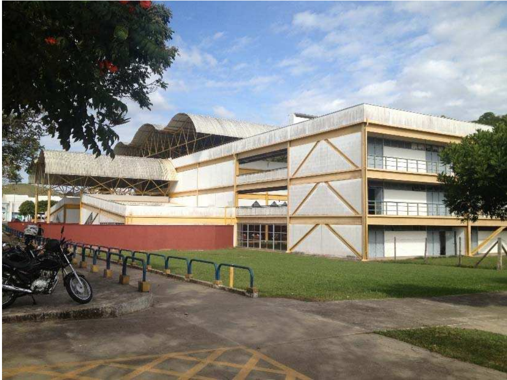
Figura 4.19 – Aspecto geral do edifício para fins institucionais, no qual se localiza a rampa de acesso.
