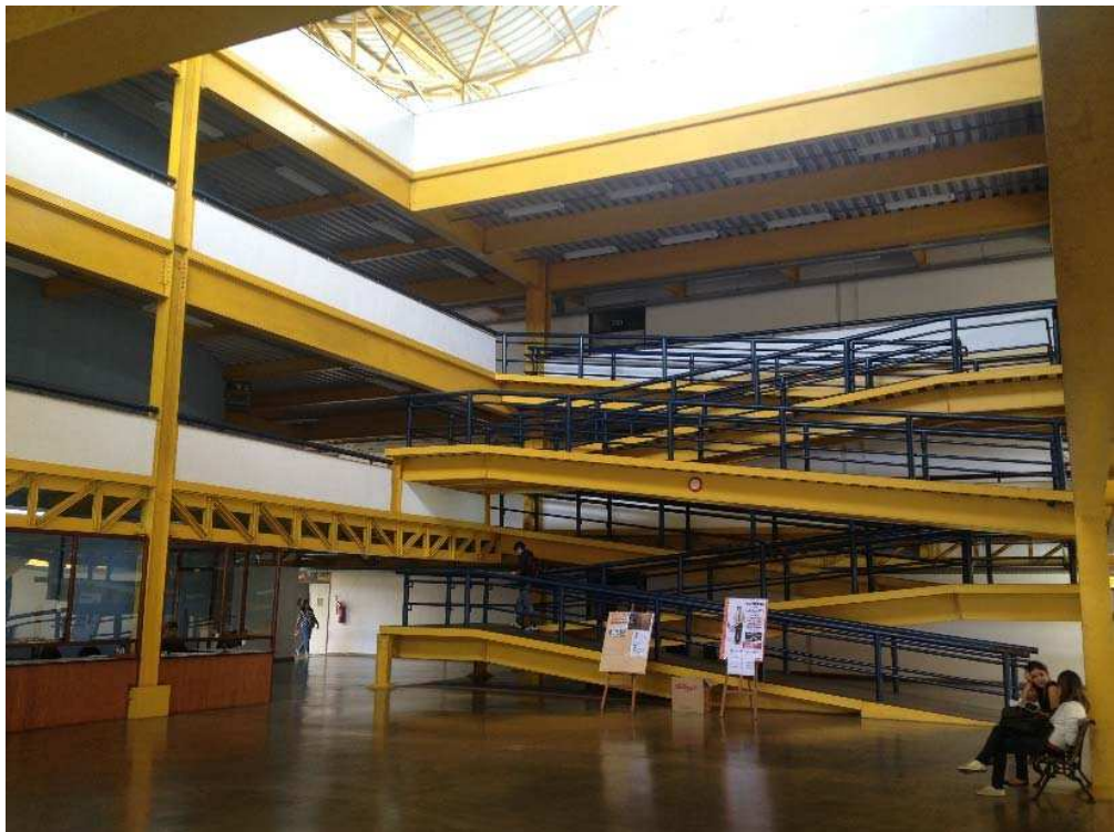
Figura 4.20 - Vista geral da rampa de acesso.
