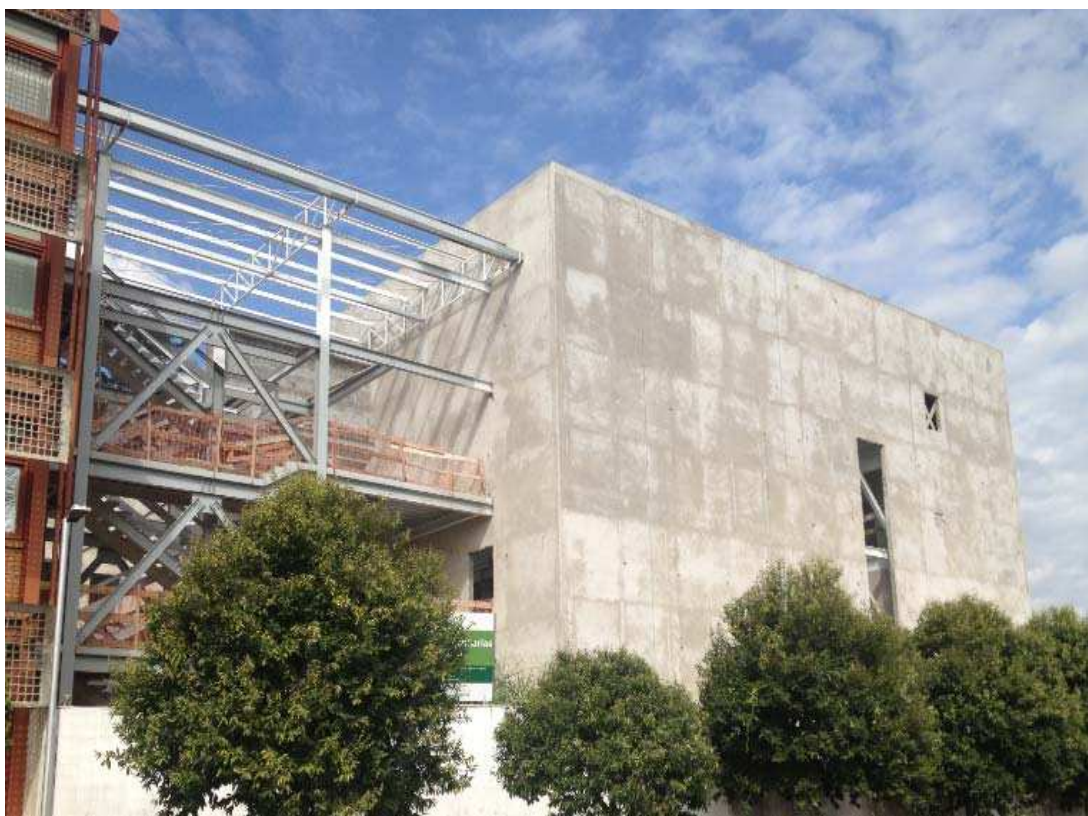
Figura 4.46 – Aspecto geral da construção do edifício para fins educacionais, no qual se localiza a passarela e a baía de acesso.
