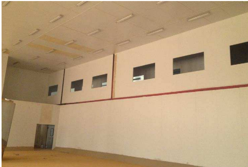
Figura 4.31 - Vista geral da passarela de acesso e da baia.
