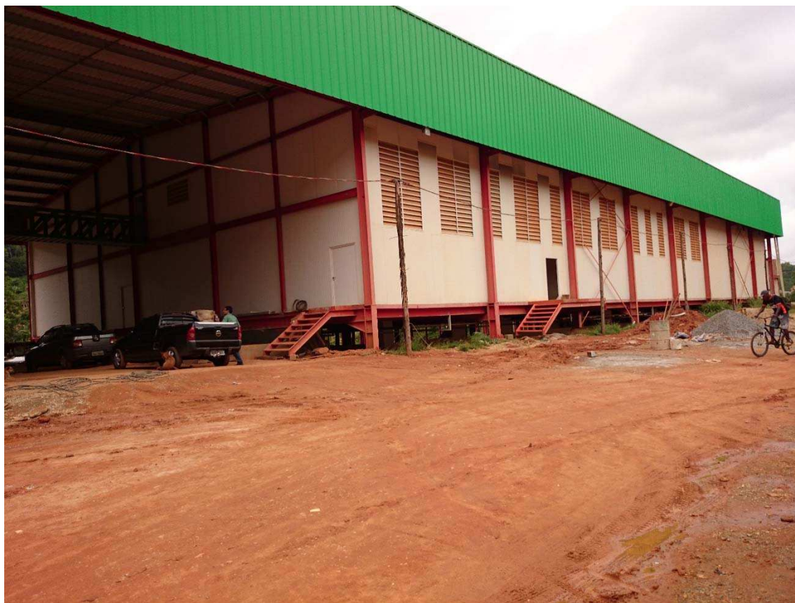
Figura 4.30 – Aspecto geral do edifício para fins industriais e institucionais, no qual se localiza a passarela de acesso.
