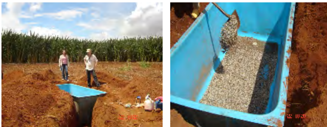
Figura 3 – Detalhes da instalação dos lisímetros de drenagem (Ld) na área experimental.
