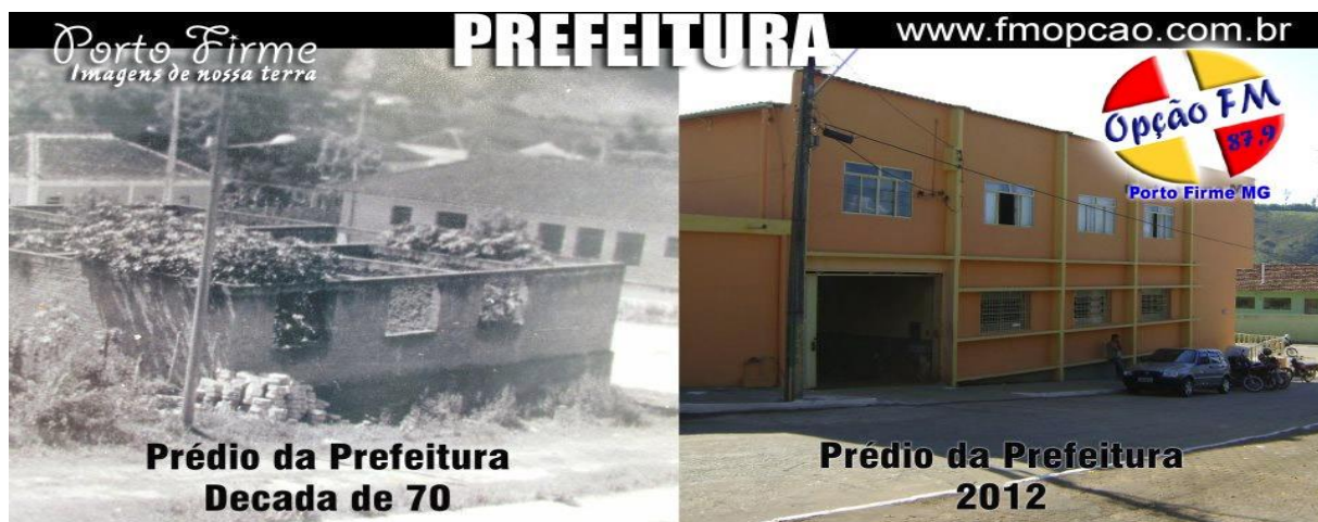
Figura 18 – À esquerda, o início da construção da prefeitura e à direita, o prédio atual
