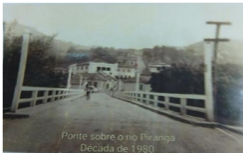
Figura 10 – Ponte “José Antônio de Araújo Quintão”, década de 1980
