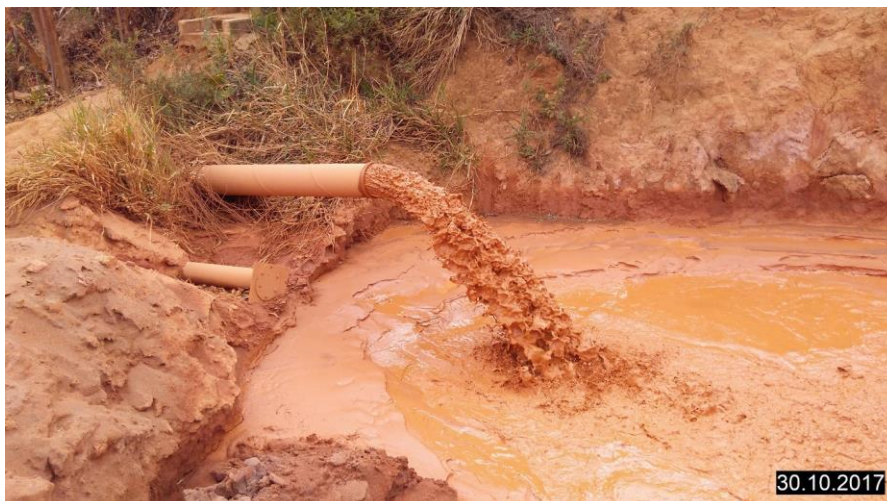
FIGURA 19: Ponto de lançamento do rejeito para sedimentação do rejeito grosso.
