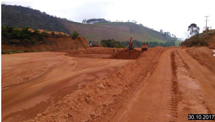
FIGURA 21: Retirada do rejeito grosso do tanque de sedimentação.
