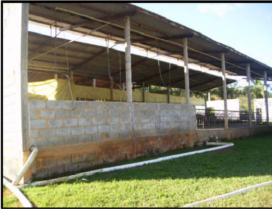
Figura 8 – Encanamento do esgoto da pocilga e seu despejo no açude.
