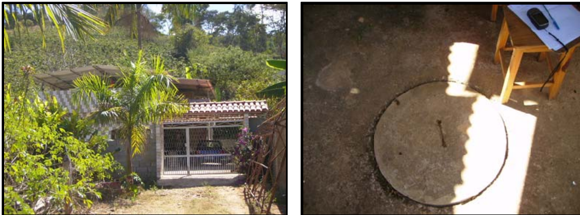
Figura 24 - Ponto de coleta 5 - Poço Escavado IV.
