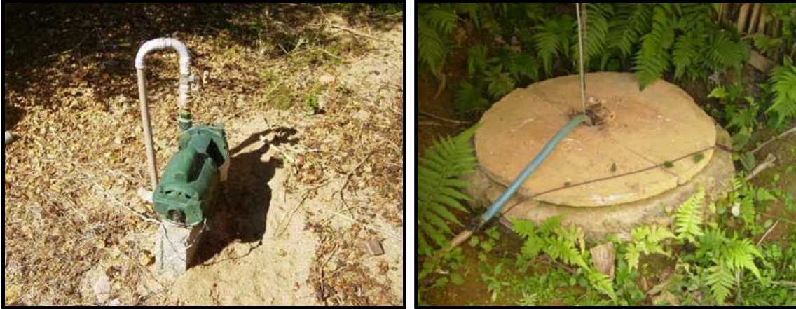
Figura 18 - Poços do tipo tubular e escavado utilizados para a captação de água na bacia do córrego do Engenho.
