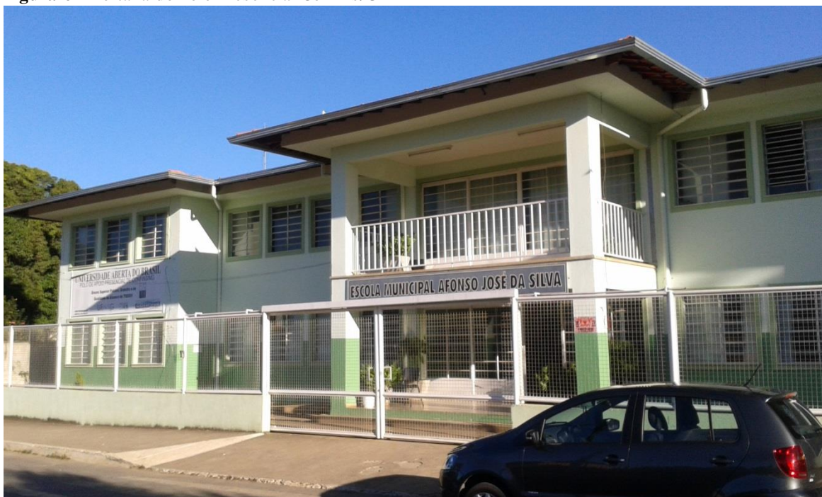
Figura 6 – Portaria do Polo Presencial Confinis/UAB
