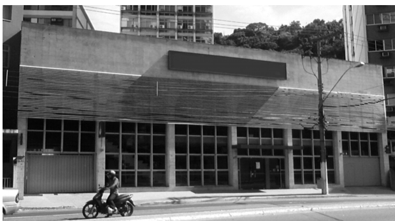
Figura 06 – Fachada principal de agência bancária com platibanda que oculta o telhado.
