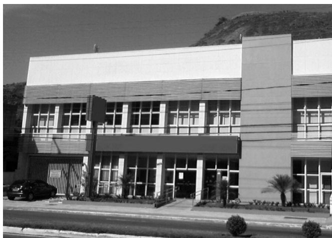
Figura 03 – Fachada principal, sem sombreamento e com um pavimento além do térreo.
