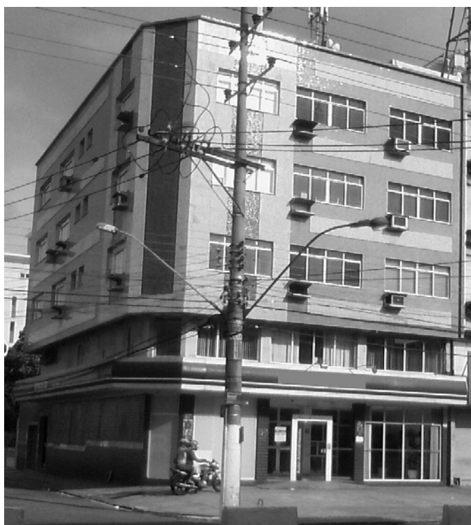
Figura 08 – Fachada principal de agência bancária de uso híbrido, com proteção solar no térreo (marquise) e no primeiro pavimento (balanço dos pavimentos superiores).
