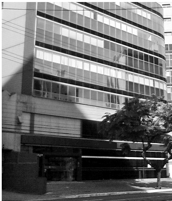
Figura 04 – Fachada principal de agência bancária de uso híbrido, com sombreamento no entorno e diversos pavimentos além do térreo.
