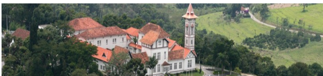
Figura 34 – Prédio Sede do IF Sudeste de Minas Gerais - Câmpus Barbacena – vista aérea 48 .
