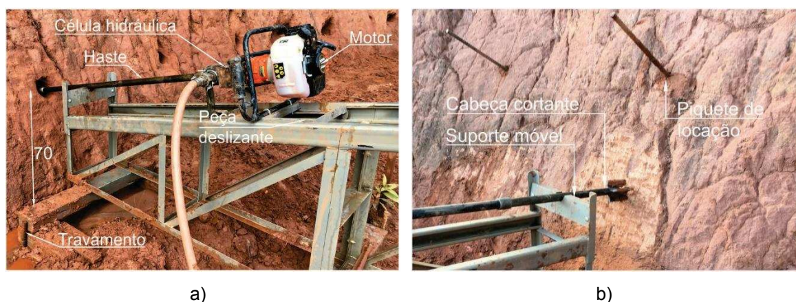
Figura 27 – Disposição e detalhes dos equipamentos de perfuração
