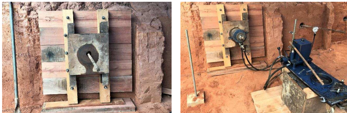
Figura 61 – Instalação da peça metálica e do macaco hidráulico
