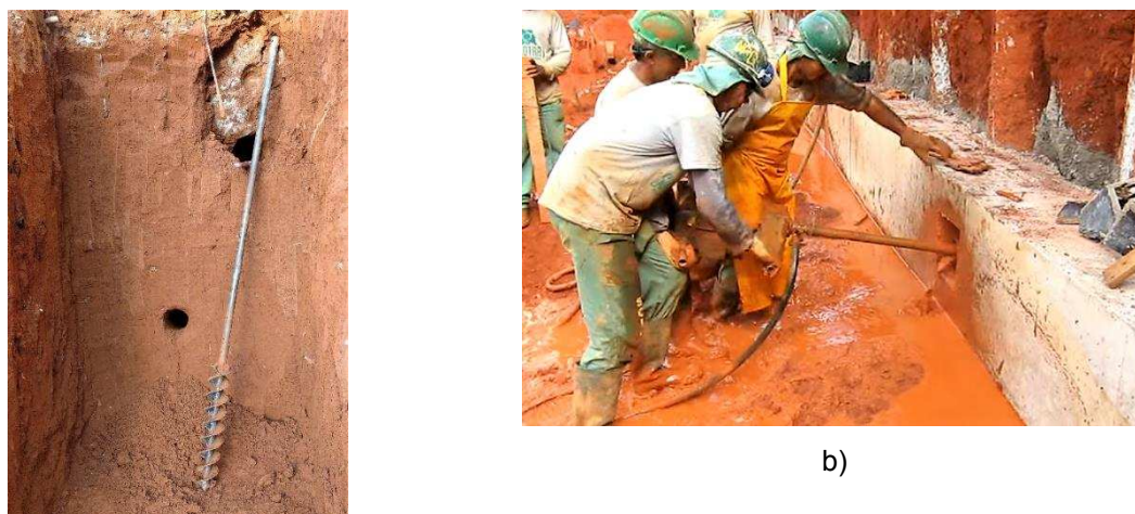
(a) Vista de um trado manual; (b) perfuração sem recirculação d'água.
