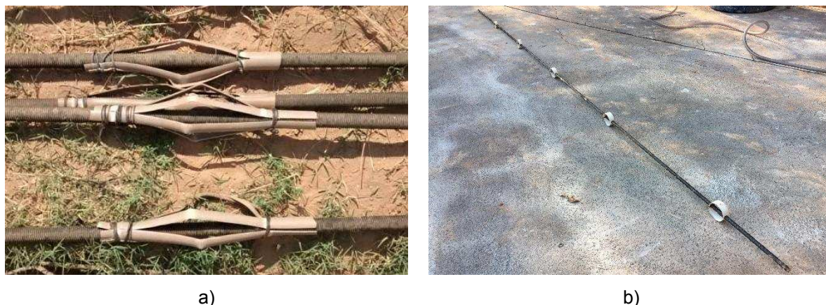
(a) Modelo de centralizador utilizado em obras no Vale do Aço-MG; (b) novo modelo de centralizador. Fonte: Autor.
