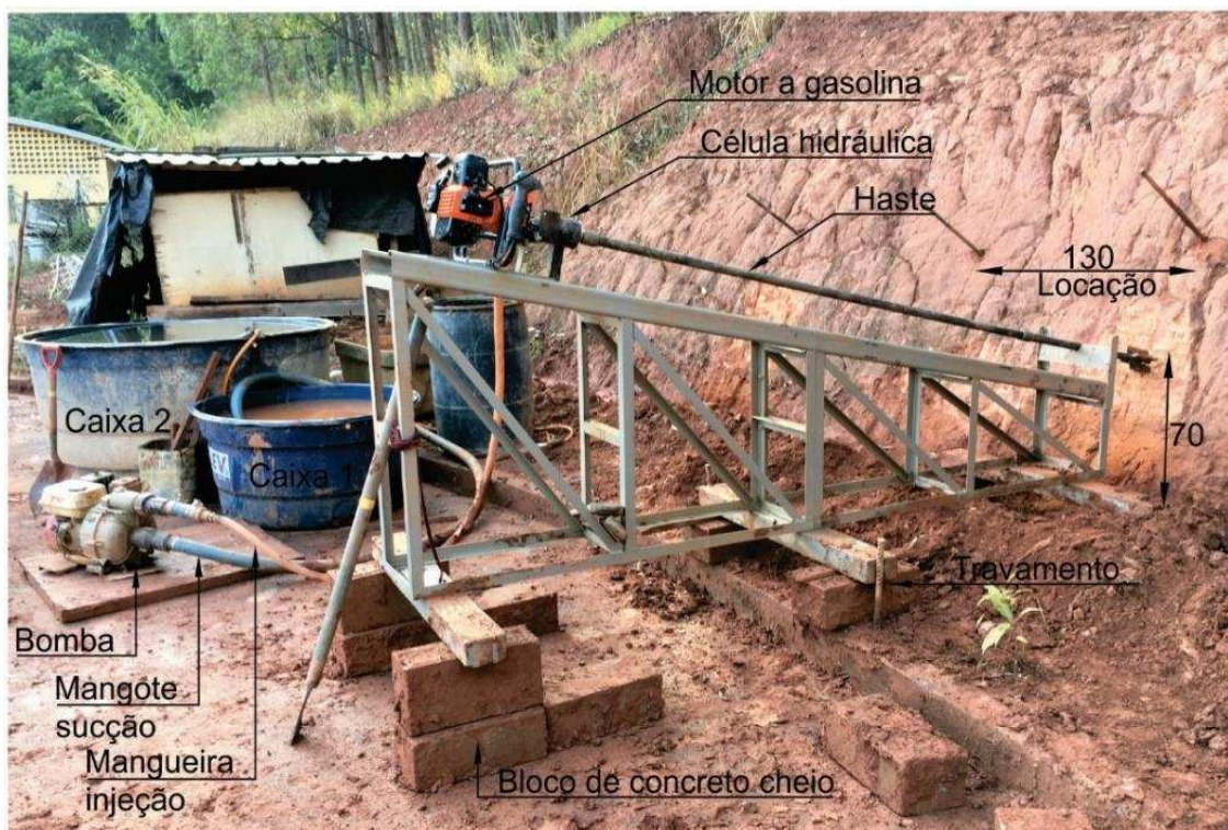
Figura 49 – Montagem do sistema de perfuração no talude
