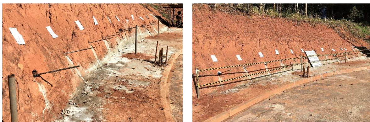
Figura 56 – Vista dos grampos executados no talude
