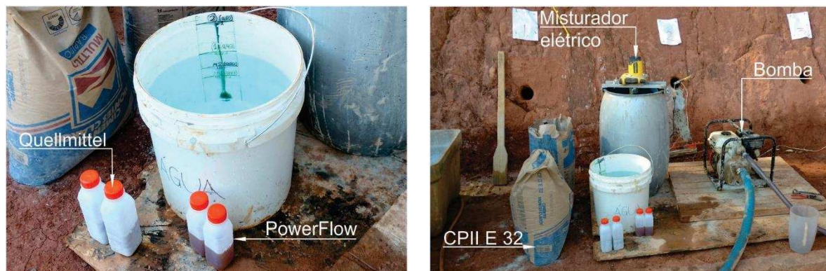
a) (a) Materiais: cimento, aditivos e água ; (b) layout do processo de injeção em campo.
