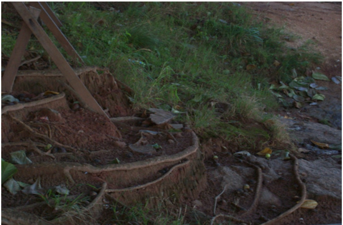
Figura 2.4 - Erosão laminar. Guarapari - ES (2008).
