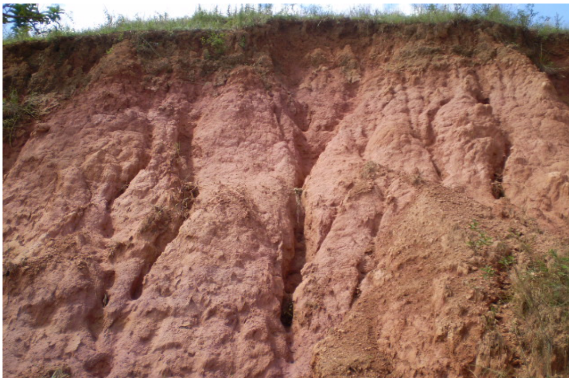
Figura 2.5 - Erosão em ravinas. Morro do Alemão, Juiz de Fora-MG (2005).
