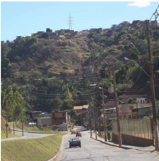
Figura 1. Vista parcial do bairro Três Moinhos, Juiz de Fora, MG.
