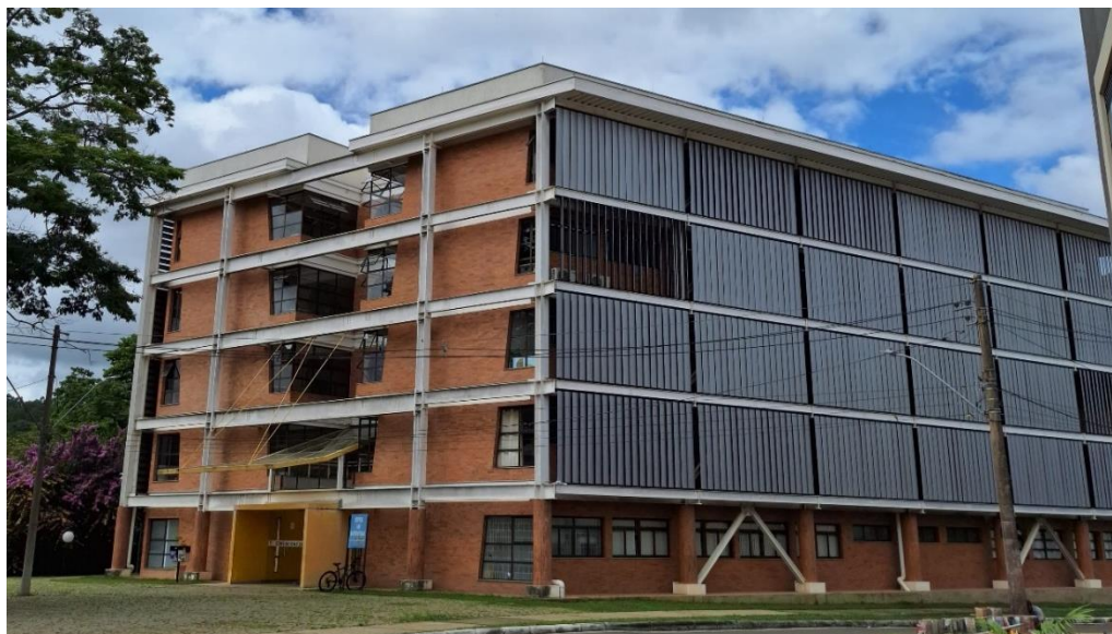
Figura 2: Edifício das Licenciaturas - UFV, campus Viçosa
