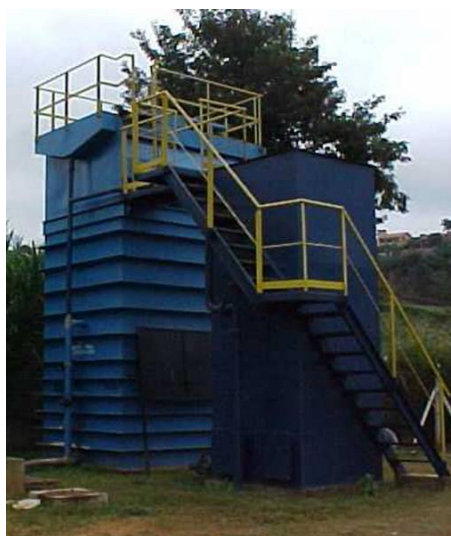
Figura 1- Reator UASB + biofiltro aerado submerso, ETE Violeira, Viçosa-MG
