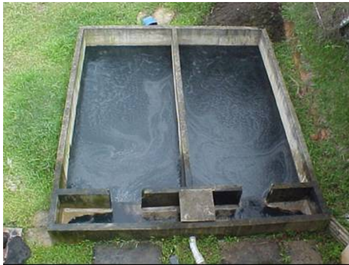
Figura 2 - Descarte do lodo do reator em leitos de secagem, ETE Viçeira, Viçosa-MG
