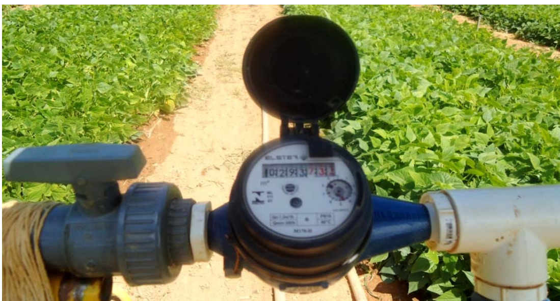
Figura 11. Hidrômetro e válvula conectados ao tubo perfurado para o controle da lâmina de água aplicada.
