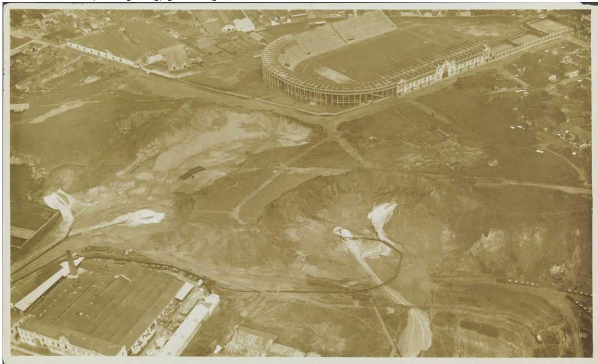
Figura 7 - HOLLAND, S. H. Obras da Empreza [sic] Melhoramentos da Baixada Fluminense Rio de Janeiro, RJ: [s.n.], [1930?]
