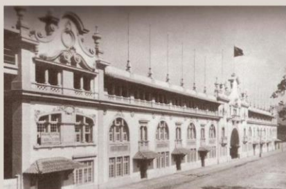
Fachada do Estádio de São Januário no ano de sua inauguração.
