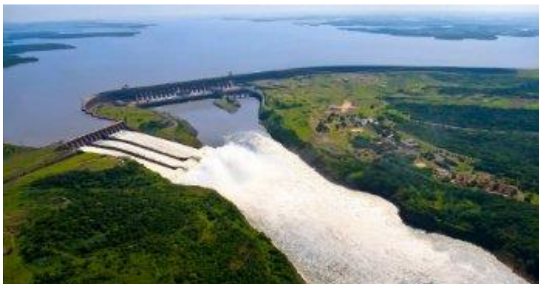
Figura 14 - Usina hidrelétrica de Itaipu, maior usina hidrelétrica das Américas
