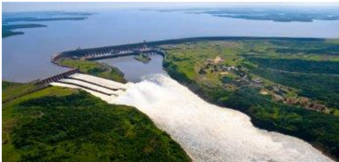
Figura 43 - Usina hidrelétrica de Itaipu, maior usina hidrelétrica das Américas
