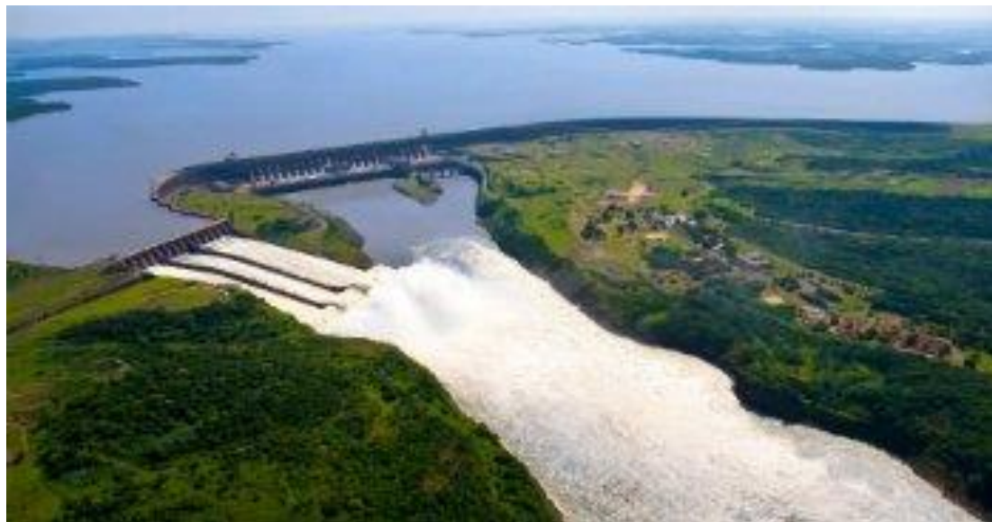
Figura 16. Usina hidrelétrica de Itaipu, maior usina hidrelétrica das Américas
