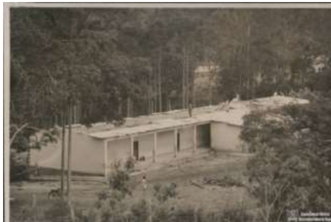
Figura 8: Construção do prédio do então Grupo Escolar Effie Rolfs
