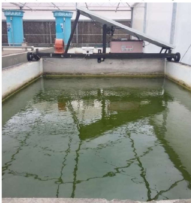
Figura 1 – Tanque mixing board com sistema propelido por energia solar fotovoltaica.
