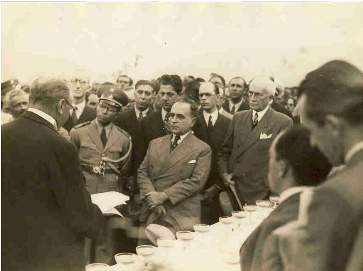
Figura 6 - Lançamento da pedra fundamental da Usina de Monlevade
