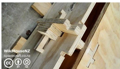
Figura 25 – Sistema de travamento das peças.
