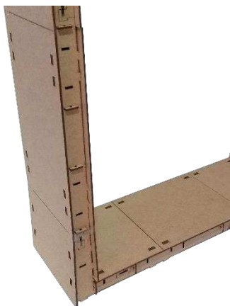
Figura 67 – Painéis de fechamento encaixados na estrutura.
