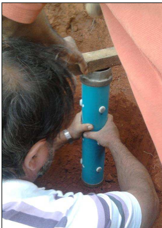
Figura 3.17 – Acoplamento do colarinho à coluna e aplicação de força na superfície superior da coluna para cravação
