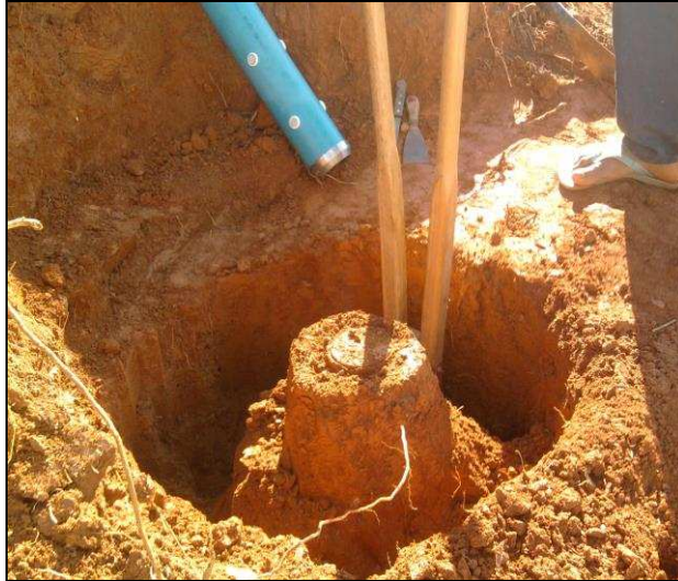
Figura 3.14 - Retirada da camada superficial e processo inicial de escavação
