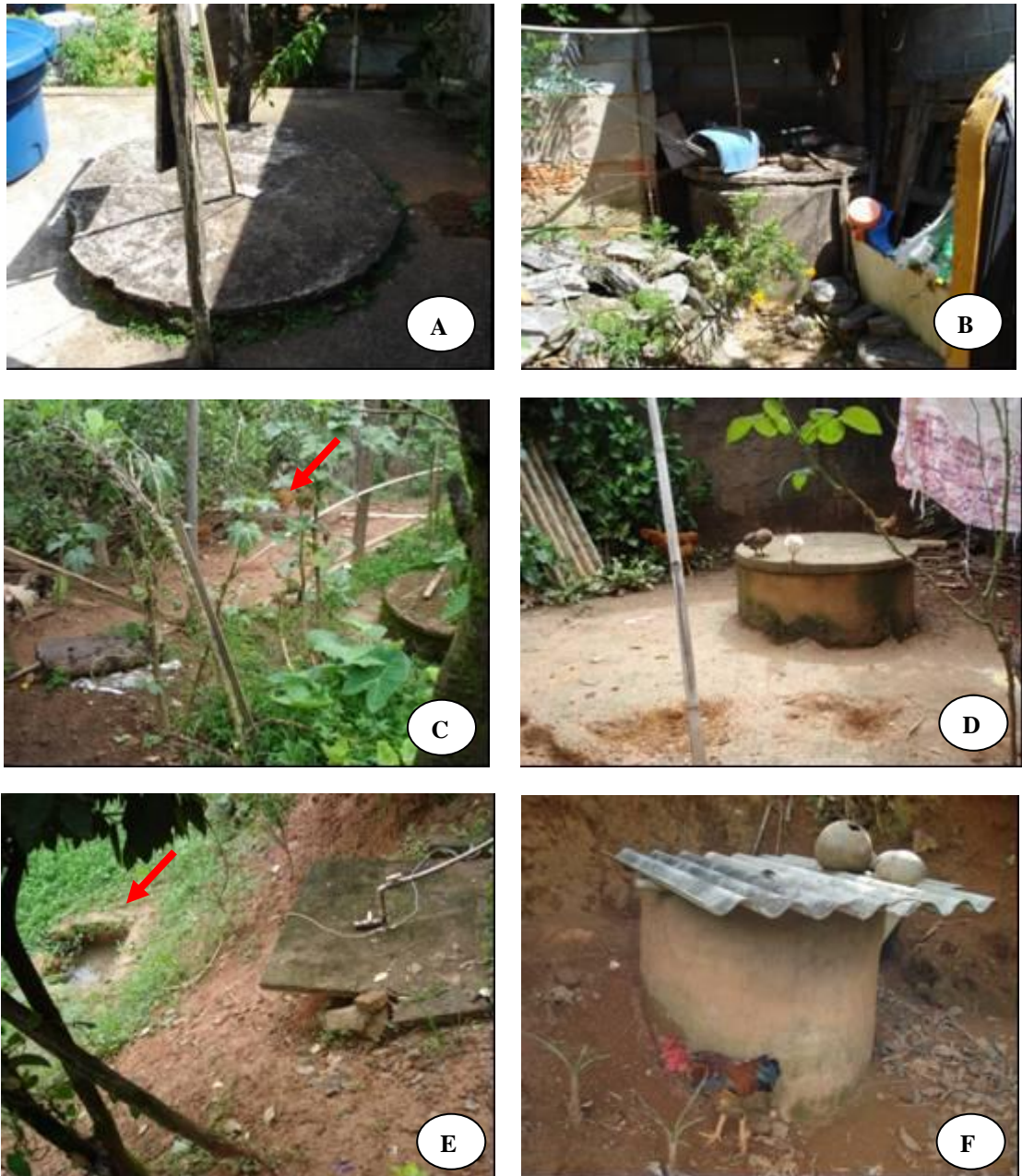
Figura 1 - Inadequações encontradas durante inspeção sanitária das soluções individuais. (A) Poço escavado no nível do terreno. (B) Falta de limpeza e conservação do entorno do poço. (C) e (D) Criação de animais no entorno dos poços. (E) Mina abandonada próxima ao poço (a mina é utilizada para criação de peixe). (F) Tampa inadequada.
