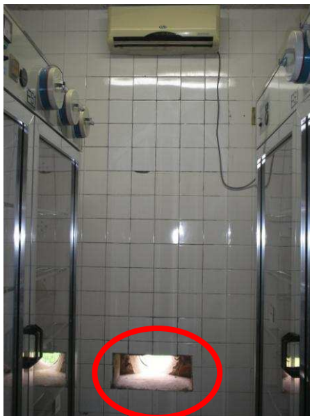
Figura 38- Parede sem o exaustor (sala 10).
