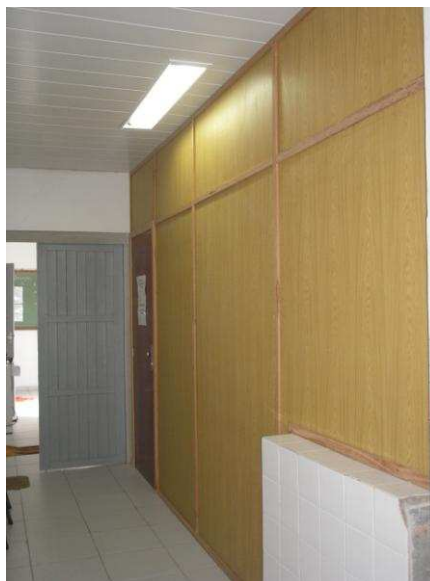
Figura 44- Fechamento de painéis de madeira na circulação.
