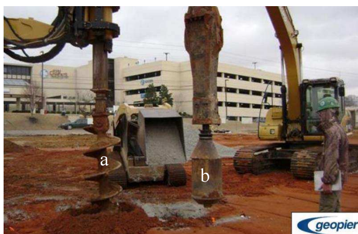
Figura 2.14: Implementos patenteados pela Geopier para construção das estacas RAP, sendo, a: trado e b: pilão. Fonte: Geopier (2015).
