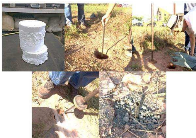
Figura 8.2: Procedimento para execução de Mini-RAP sem ponta
