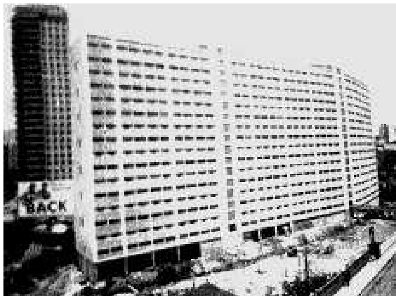
Figura 3 – Edifício Japurá, em São Paulo.
