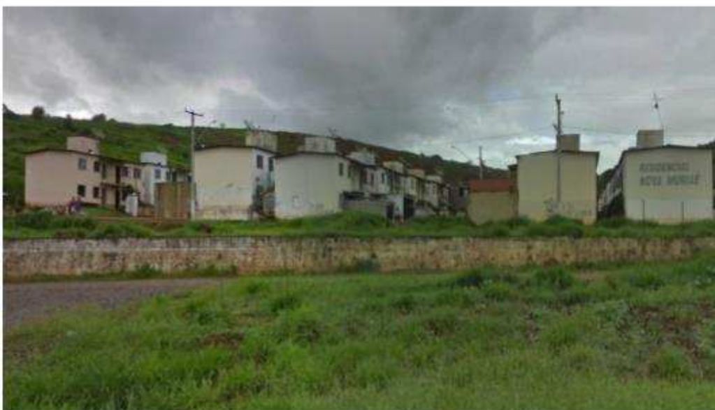
Figura 12 – Condomínio Residencial Nova Muriaé, 2018.
