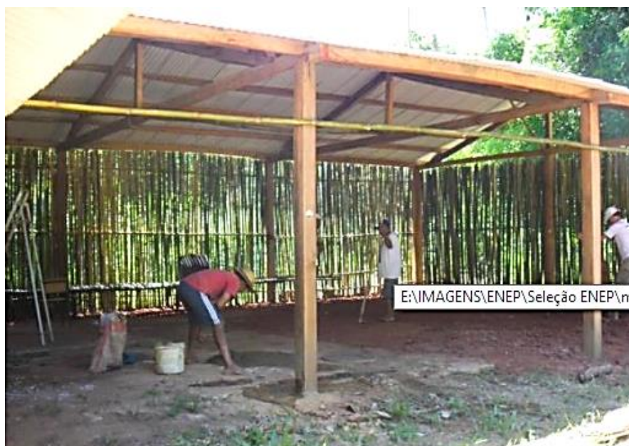
Foto 06 - Mutirão de construção da plenária da ENEP.
