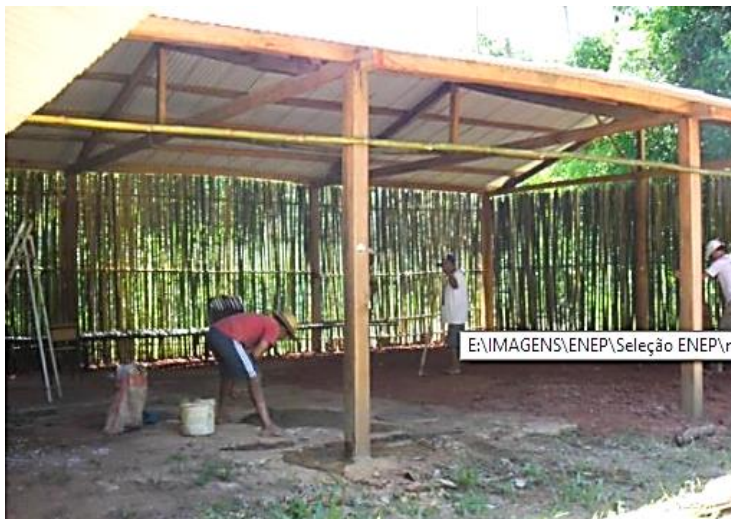
Foto 08 - Mutirão de construção da plenária da ENEP.
