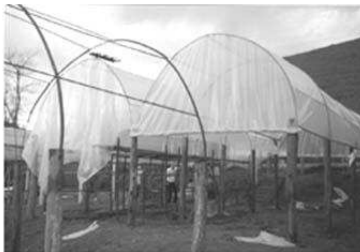
Figura 10 - Colocação da lona plástica na casa de vegetação sem lanternim.
