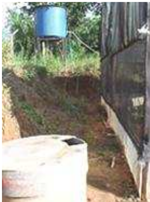
Figura 21 - Proximidade do tratamento S do talude.
