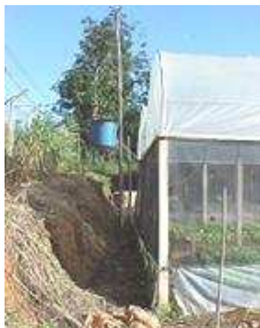
Figura 20 - Proximidade do tratamento T do talude.
