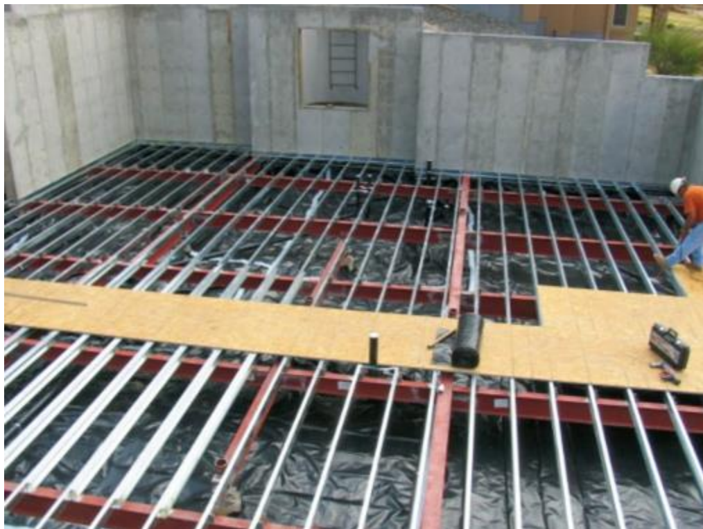
Figura 1.2 – Aspecto de um sistema de piso seco durante a montagem
