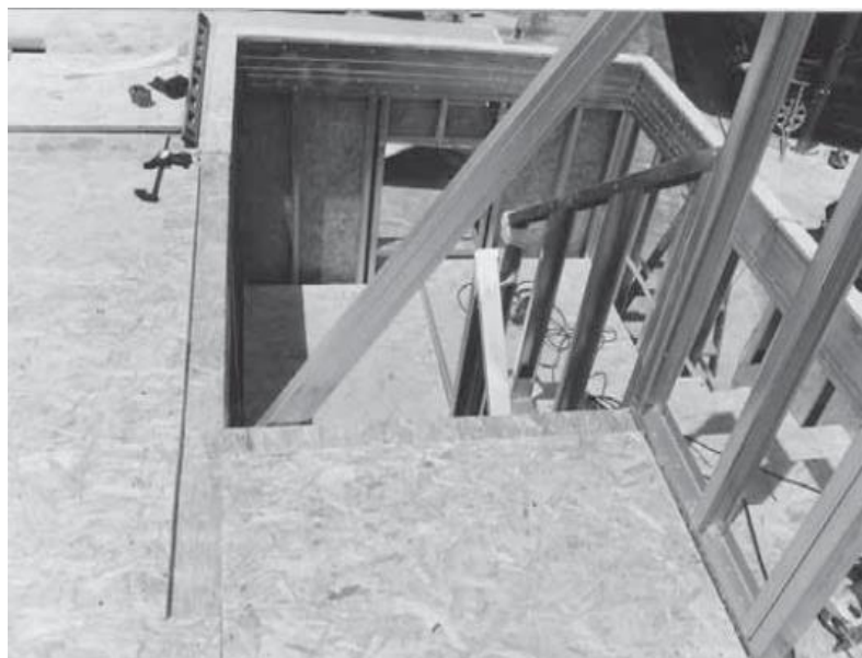
Figura 2.4– Sistema de piso seco em LSF com utilização de placas de OSB
